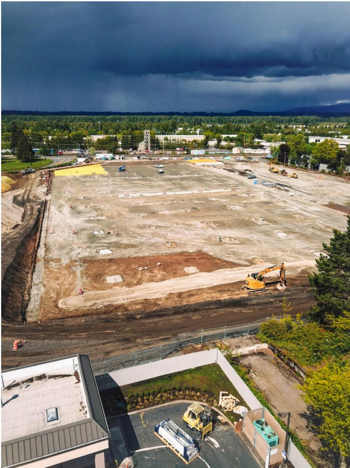
Sitio de construcción de ProLogis al 29/04/24.
